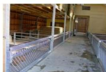
Ingerichte Schaapskool in het zuiden van het land
